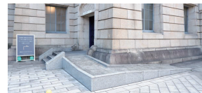
● 出入口（本堂）の傾斜路
