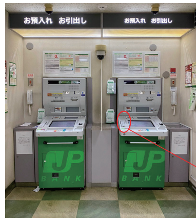
車椅子使用者が手すりを掴み、体を引き寄せて操作できるATM。ATMの上部照明はグレアカットルーバーを採用
