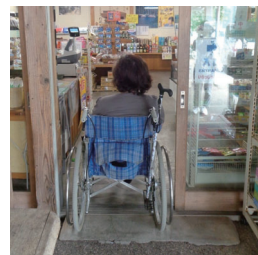
●売店出入口幅82cm(引き戸) 扉下枠部は傾斜にて段差解消
