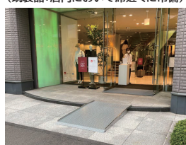
車椅子用据え置き型スロープ (特注鉄板敷:テナント側で設置)
