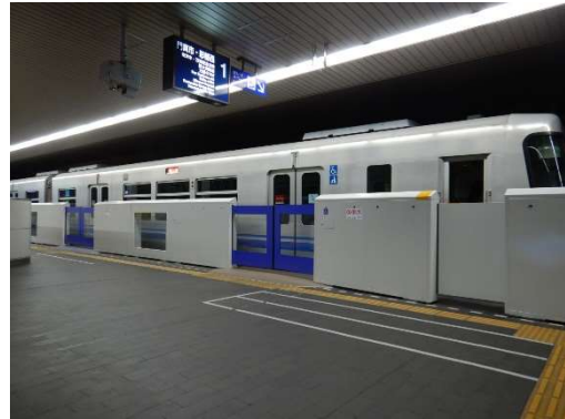
大阪高速鉄道(株) 千里中央駅
