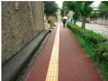
誘導ブロックの敷設
