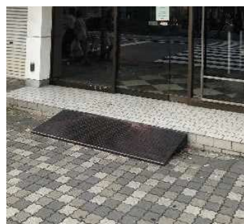
●鉄板敷を道路内に設置。 段差解消の鉄板敷は、歩道上に設置されており、通行の障害となる。
