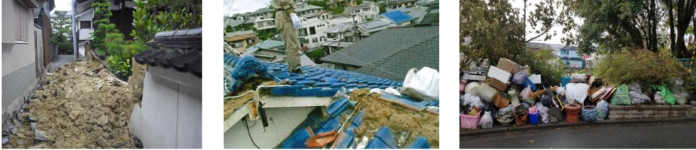
(左・中央) 大阪府北部地震の被害の様子 (右) 台風21号時に積み上げられた災害ごみ
