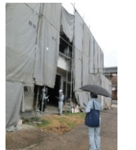
解体工事現場指導(建設リサイクルパトロール)
