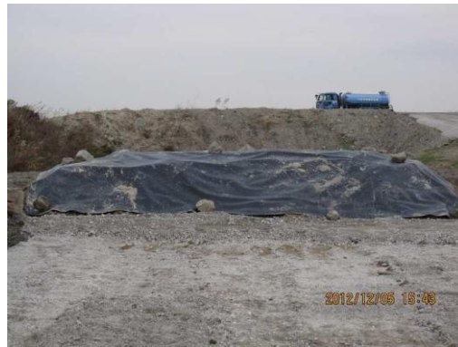
埋立完了後のシート保護状況
