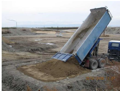
埋立作業状況
