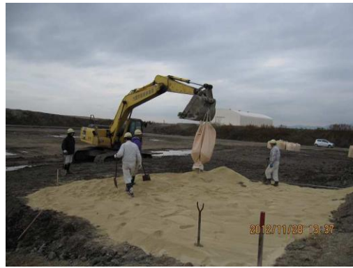
ゼオライト敷設状況
