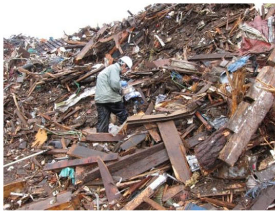
<野田村仮置場での放射線量測定の様子（H23.6）>
