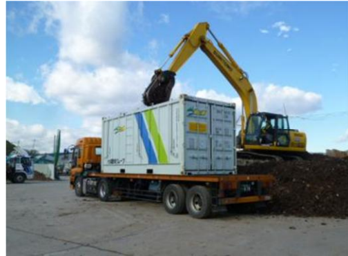
<コンテナへの積込み (H24. 11. 14~15) >
