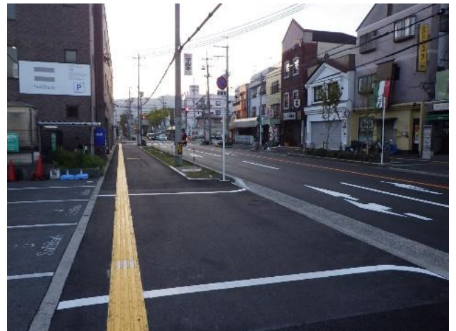
視覚障がい者誘導用ブロック設置
