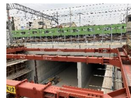
〔道路と鉄道の立体交差〕
