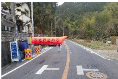
空気式遮断機による通行規制
