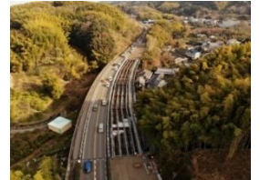
〔道路の整備（4車線化）〕
