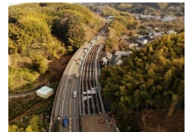
国道170号(若樫工区)
