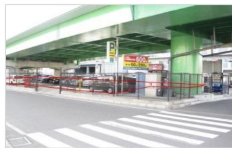
▲国道170号新町跨道橋高架下 (東大阪市)
