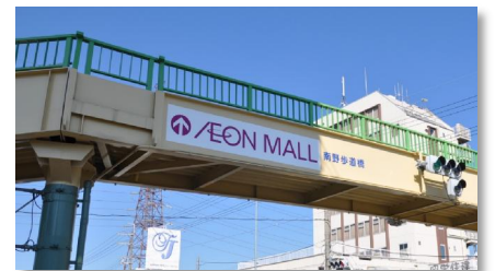
▲一般国道170号 南野歩道橋（四條畷市）
