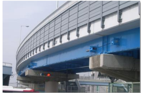
落橋防止対策
