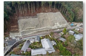
〔道路法面対策〕
