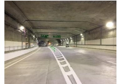
阪神高速 大和川線 (令和2年3月供用)
