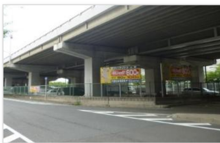
▲国道423号寝坂高架橋下 (吹田市)
