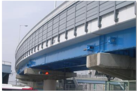
落橋防止対策
