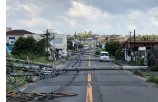
倒壊による道路閉鎖
