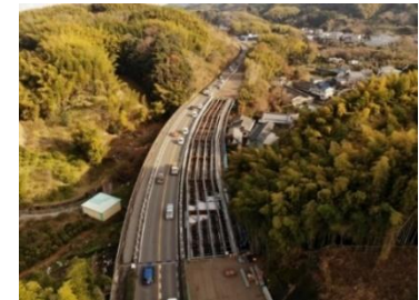
国道170号(若樫工区)
