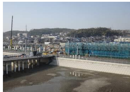
道路と鉄道の立体交差化 (府道美原太子線・富田林市)
