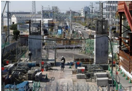
道路と鉄道の立体交差化 (〔都〕十三高槻線・吹田市)
