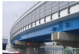
落橋防止対策
