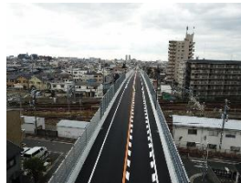
〔道路と鉄道の立体交差〕
