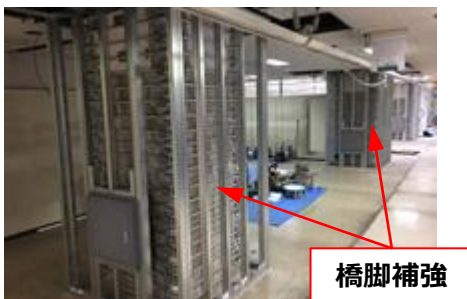
鉄道駅耐震補強の状況
