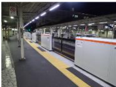
可動式ホーム柵の設置（扉式）
