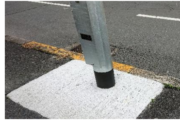
道路照明灯の更新
