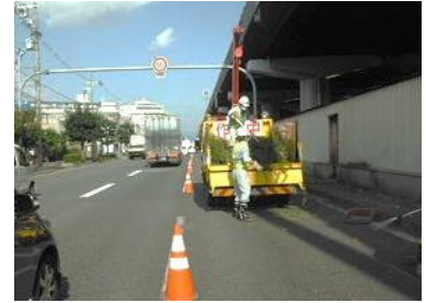
道路施設の清掃
