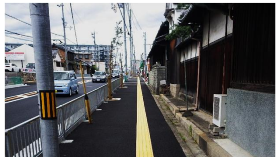
視覚障がい者誘導用ブロック設置
