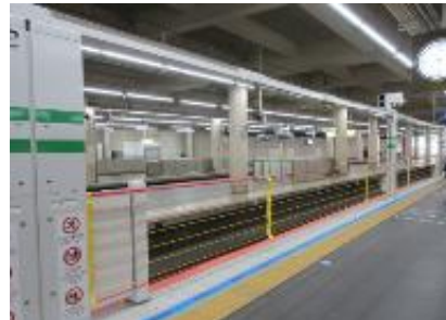
可動式ホーム柵の設置（ロープ式）
