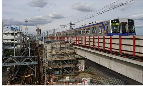
連続立体交差化 (南海本線・高師浜線・高石市)
