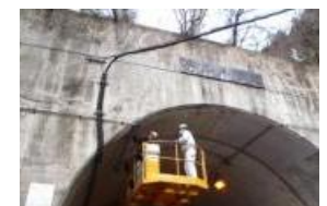
〔トンネル点検〕
