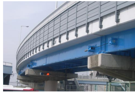
落橋防止対策
