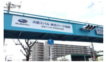
▲一般国道170号 伊加賀歩道橋(枚方市)
