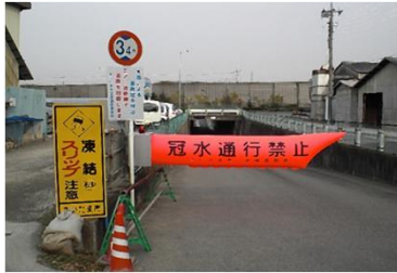
冠水時のエア遮断機（固定式規制設備） 出典：国土交通省 NETIS新技術情報提供システム
