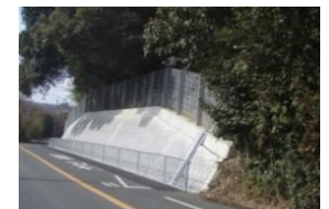
〔道路法面对策〕
