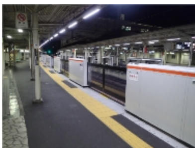
可動式ホーム柵の設置（扉式）
