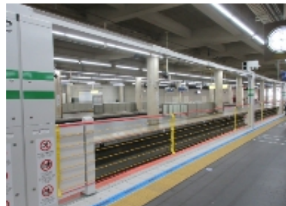
可動式ホーム柵の設置（ロープ式）
