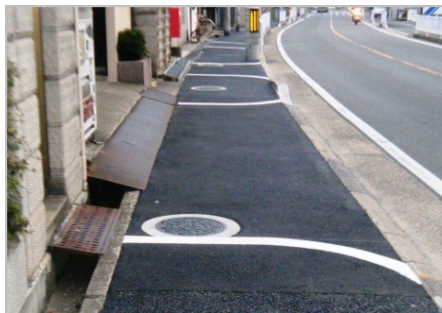
段差、勾配の改善
