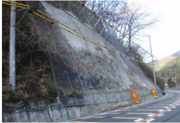
落石・法面崩壊防止対策
