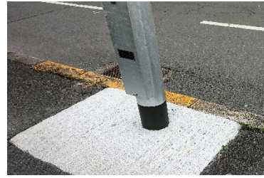
道路照明灯の更新
