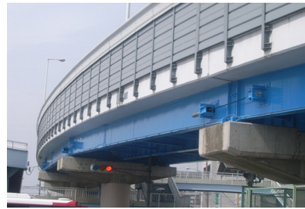
落橋防止対策
