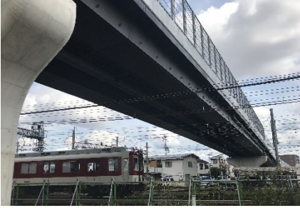
道路と鉄道の立体交差化 (〔都〕堺港大堀線・松原市)
