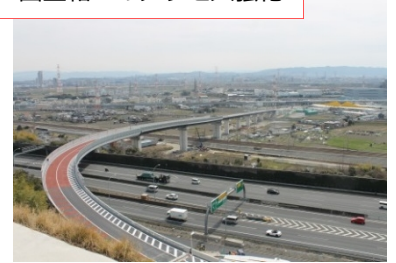
高槻東道路 (新名神高速道路アクセス) (2017.3 供用開始)
