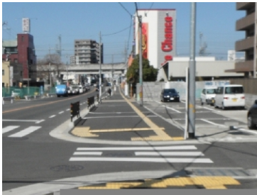
歩道の整備 府道岸和田港塔原線（岸和田市）
