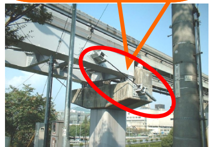
耐震対策(大阪モノレール)
