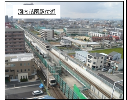
河内花園駅付近 近鉄奈良線（東大阪市） 平成 25 年 2 月現在
