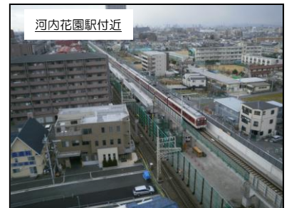
河内花園駅付近 近鉄奈良線（東大阪市） 平成 24 年 2 月現在
