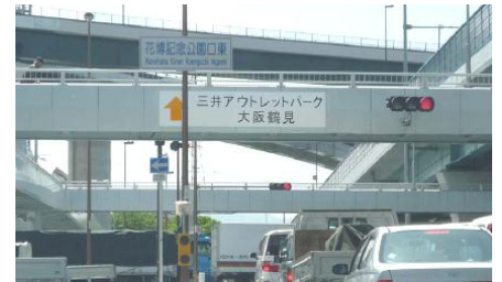
主要地方道大阪中央環状線 葺島歩道橋
