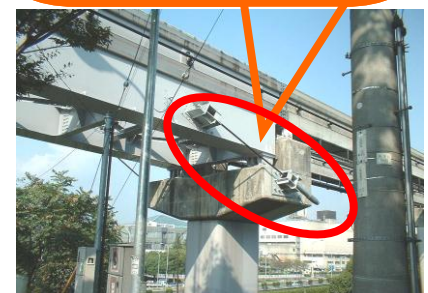
耐震対策（大阪モノレール）
