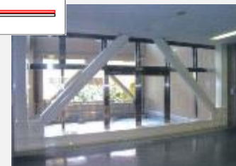
建物の耐震化 (補強材の設置)
