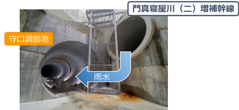
松生立坑 (下水道増補幹線を地下河川に接続)
