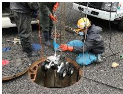
詳細点検状況 （カメラ調査）
