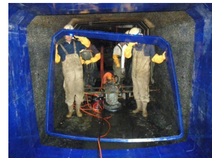
対策実施状況 （管更生工法）
