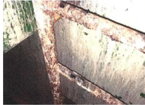
汚泥濃縮棟 タラップ (拡大)
