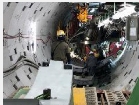
門真守口増補幹線（施工中）
