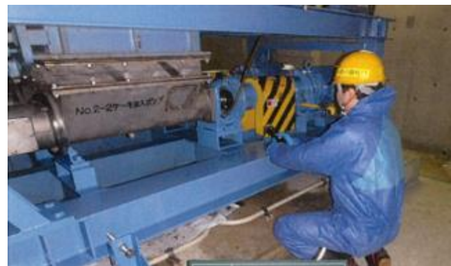
設備の点検状況
