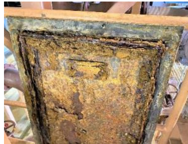
汚泥濃縮棟 蓋 裏側 (拡大)
