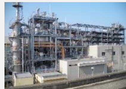
省エネ機器の例 (過給式流動焼却炉)
