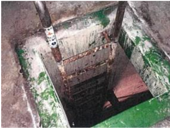
汚泥濃縮棟 タラップ (全景)
