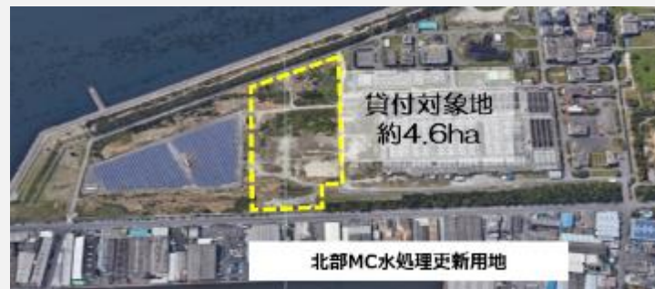
▲北部MCにおいては、地方公営企業法適用後初となる長期貸付契約（29年11か月）を締結し、総額54億円の自主財源を確保
