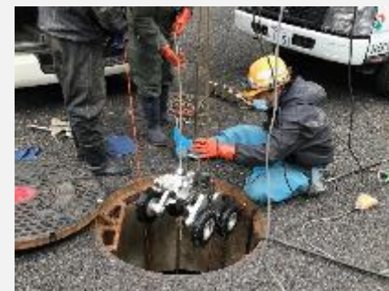
管渠の点検状況 (カメラ調査)
