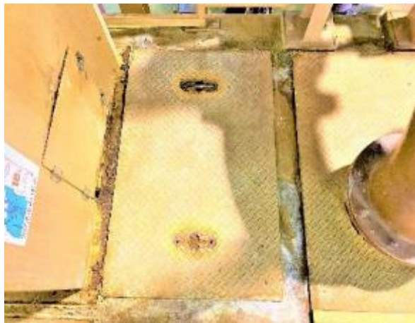
汚泥濃縮棟 蓋 (全景)
