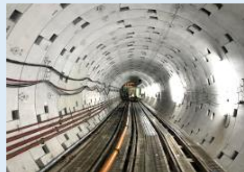
▲下水道増補幹線（施工中）
