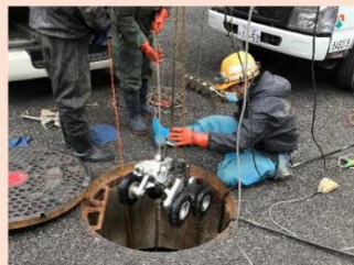
▲管渠の点検調査状況
