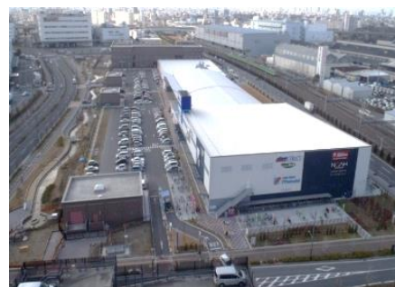
写真 22 用地の貸付事例(竜華水みらいセンター) (水処理施設の大部分を地下式とし、その上部空間を民間事業者に貸付けています。)
