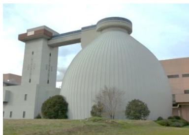
写真 20 消化槽(原田水みらいセンター)
