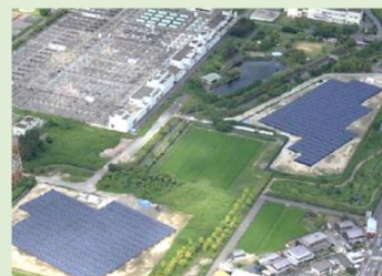
▲太陽光発電事業（渚水みらいセンター）
