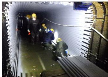
写真 7 管渠の改築更新の例
