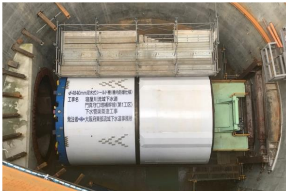
写真 14 シールドマシン (門真守口増補幹線)
