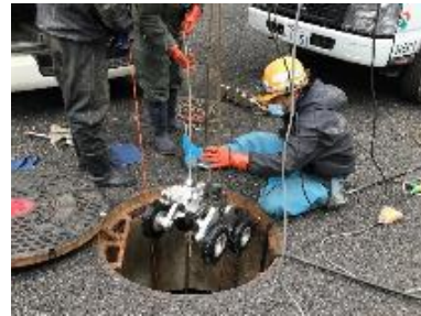
写真10 管内調査状況
