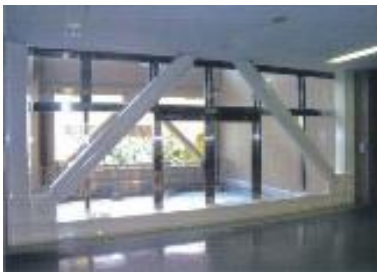
写真 17 建物の耐震化(補強材の設置)
