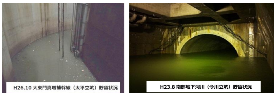
写真3 下水道増補幹線・地下河川における雨水貯留状況
