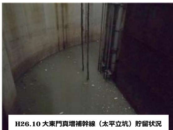
写真－2 下水道増補幹線 2 ・地下河川 3 における雨水貯留状況
