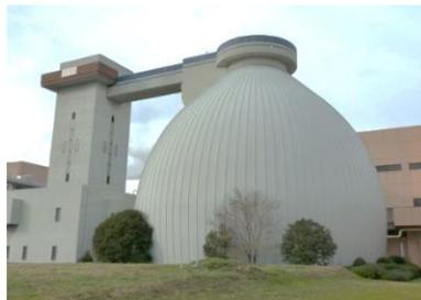
写真 19 消化槽(原田水みらいセンター)
