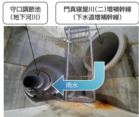
写真 12 下水道増補幹線と地下河川
