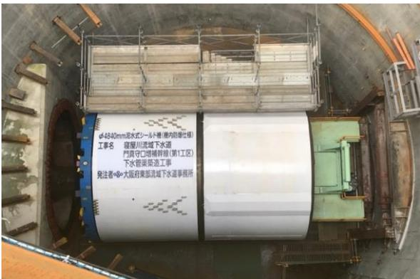
写真 13 シールドマシン (門真守口増補幹線)
