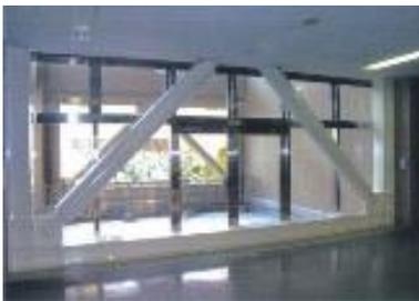
写真 16 建物の耐震化(補強材の設置)
