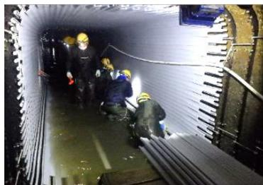
写真7 管渠の改築更新の例
