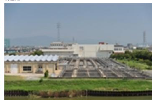
豊橋市公共下水道中島処理場
