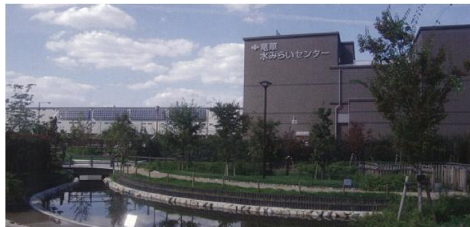
処理場の建設 竜華水みらいセンター (高度処理対応)
