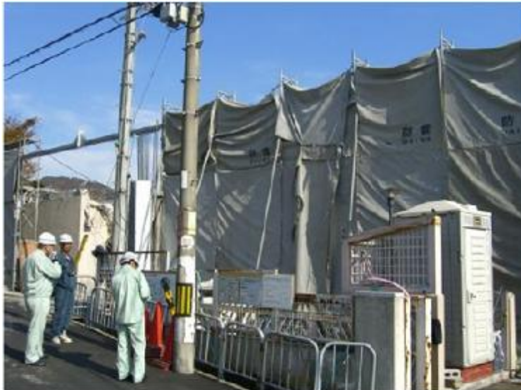
アスベスト解体現場パトロール
