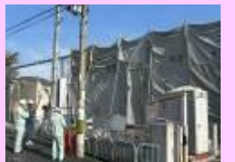
アスベスト解体現場パトロール
