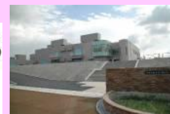
水みらいセンター (下水処理場)
