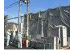
アスベスト解体現場パトロール
