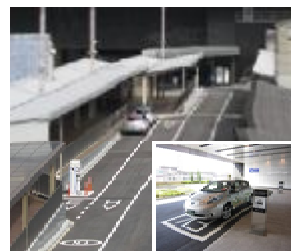
JR 大阪駅 EV/HV タクシー乗場
