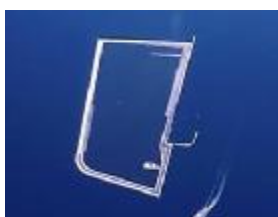
フェニックス計画 大阪沖埋立処分場
