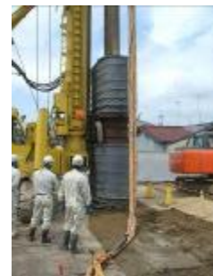
土壌汚染の除去措置の実施状況
