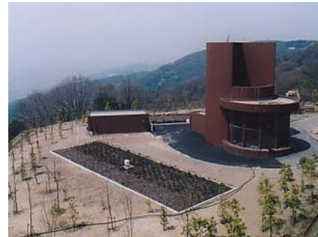
土壌による大気浄化システム（生駒山上）
