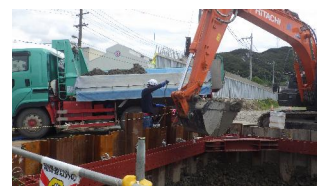
土壌汚染の拡散防止措置の 現地確認状況
