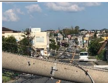
倒壊した電柱
