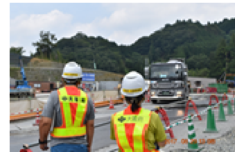
流入車規制の立入検査
