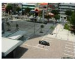
透水性・保水性舗装
