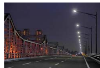
LED道路照明
