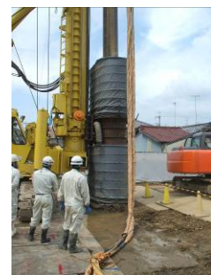
土壌汚染の除去措置の実施状況
