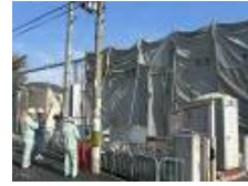
アスベスト解体現場パトロール
