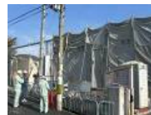
アスベスト解体現場パトロール
