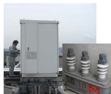
PCB（コンデンサ）保管状況の立入検査
