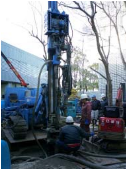
図 - 15 地中熱ヒートポンプシステムにおける熱交換井の掘削状況
