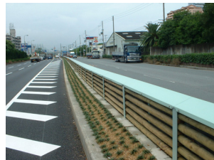
地球温暖化対策としても期待される間伐材を有効活用した「木製低層遮音壁」
