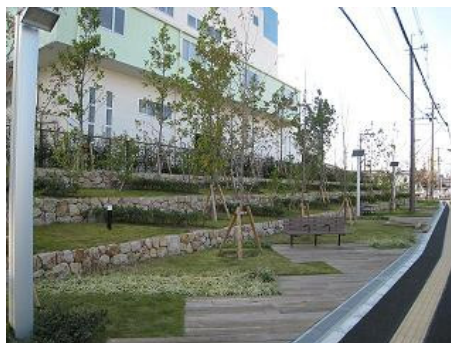
八尾市立リサイクルセンター
