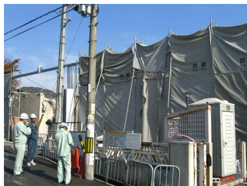
アスベスト解体現場パトロール
