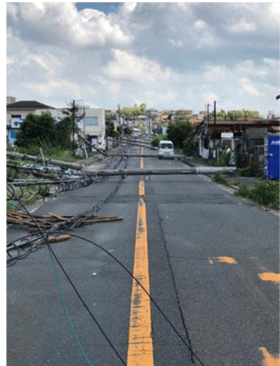
図 1-10 2018 年台風第 21 号による 電柱倒壊（泉南市） 出典：令和元年版防災白書
