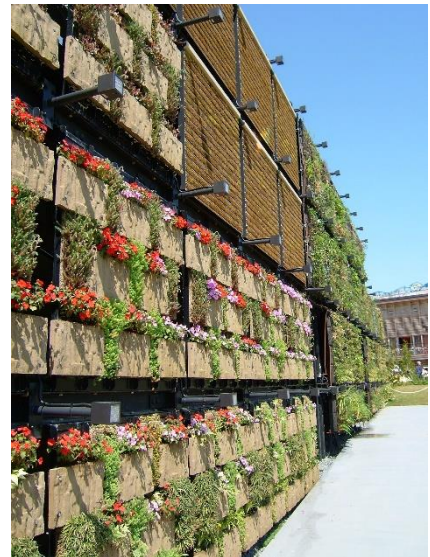
大規模壁面緑化「バイオラング」 （写真提供：公益財団法人都市緑化機構）
