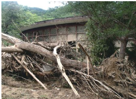
2018年7月豪雨による被害(能勢町)
